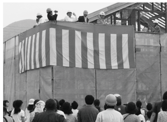
平成28年5月 石打支店上棟式・もちまき
