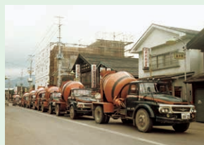
本店新築の工事
