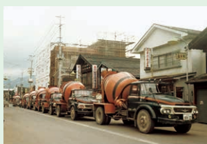
本店新築の工事
