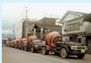
本店新築の工事
