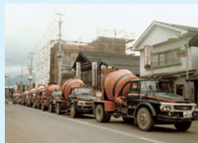
本店新築の工事
