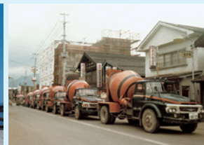
本店新築の工事
