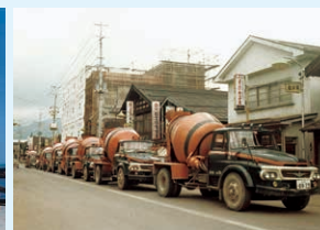
本店新築の工事
