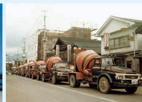
本店新築の工事
