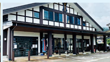
石打支店新築
